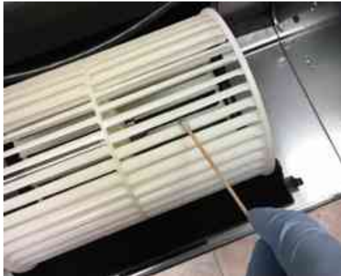
Figura 2 – prelievo dei microrganismi mediante tamponi di superficie
